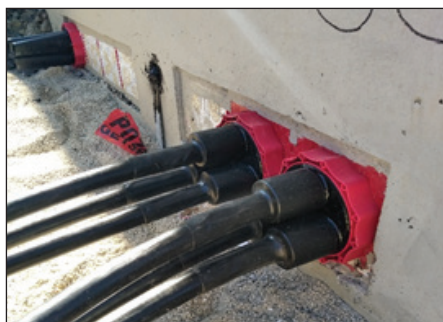
Brtvljenje SN kabela sa HSI 150-D3/58
