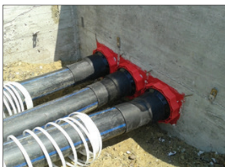
Brtvljenje glatke cijevi Ø 125mm sa HSI 150-D1/125-KS
