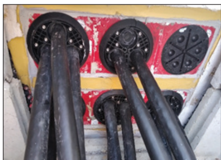
Brtvljenje SN i NN kabela sa HSI 150-DG- 3/24-54
