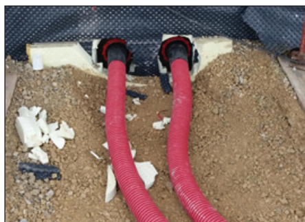
Brtvljenje rebraste cijevi Ø 110mm sa HSI 150-D1/110-KS
