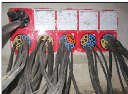
Brtvljenje NN kabela sustavom Segmento: HSI 150-SEG-1x8/15-2x6/21
