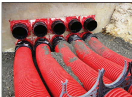
Brtvljenje rebraste cijevi Ø 160mm sa HSI 150-M 168-WR
