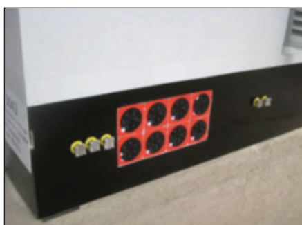
HSI 150-2x4 K/100 (nakon betoniranja)
