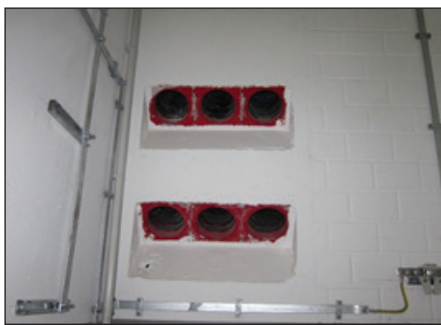
HSI 150-1x2 K2 S30°/300 (nakon betoniranja)
