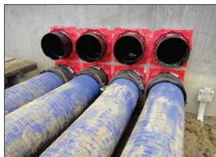
Hateflex 14150 u zidnim uvodnica sa KES-M 150-D
