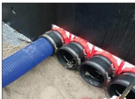
Hateflex 14150 u zidnim uvodnica sa KES-M 150-D
